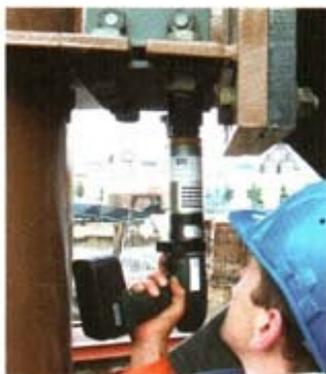
**Bild 1.** Drehmomentgenaue Akkuschrauber – auch für schwer zugängliche Stellen
